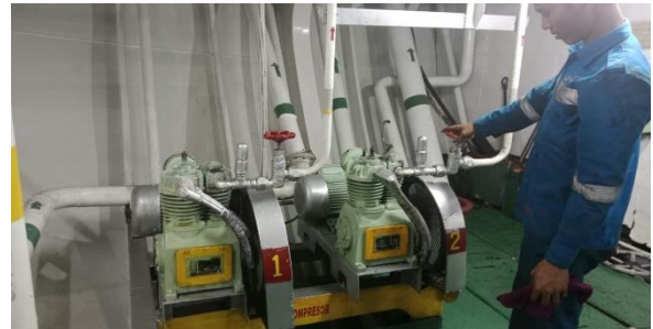
Gambar 2 Cek Tekanan Air Starting Angin Pada Compressor
