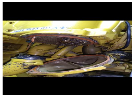
Gambar 3 Kotoran dan kerak pada cooler mesin induk
